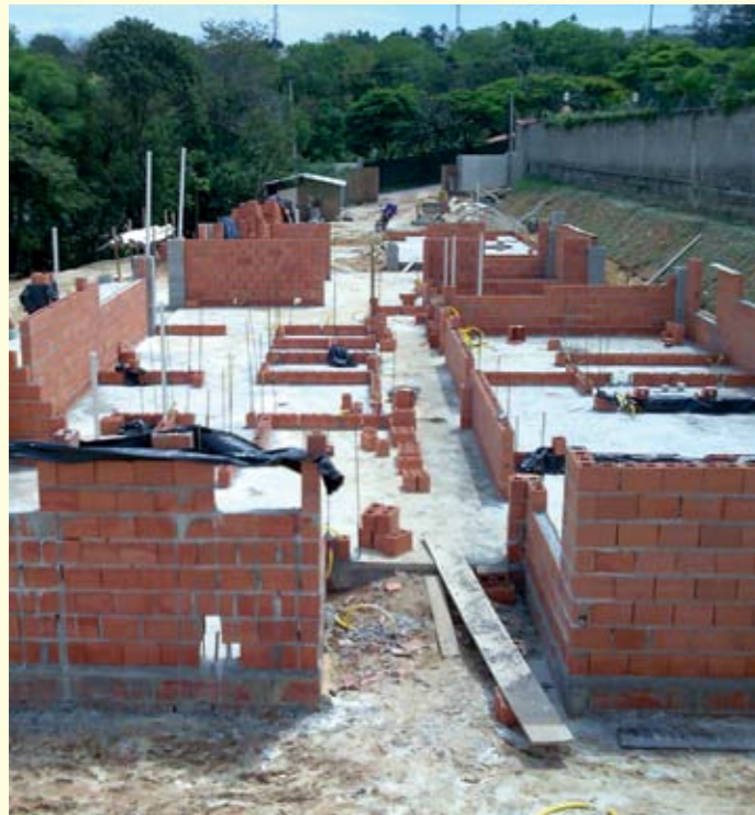
Em Indaiatuba/SP: Better Residências constrói casas de alto padrão com bloco estrutural cerâmico.
